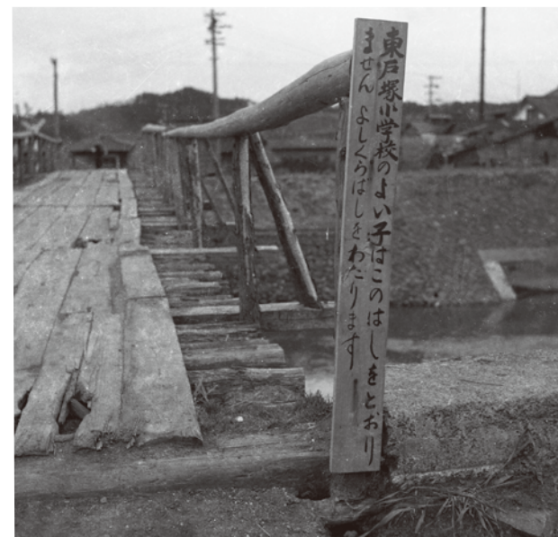
元吉倉橋(年代不詳) / 提供: 坂本写真
