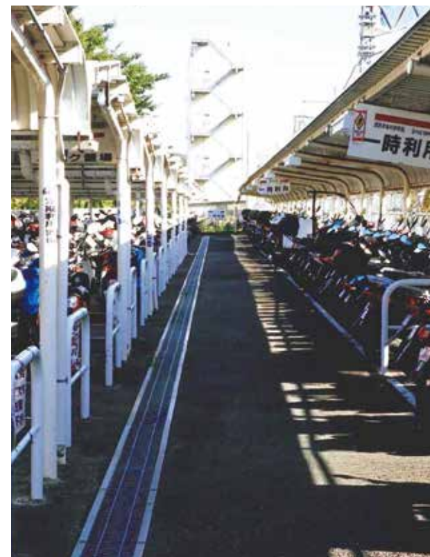
真っ直ぐに伸びた通路は、かつての引込線の名残が… 戸塚駅東口の駐輪場 / 提供:田中一好さん
