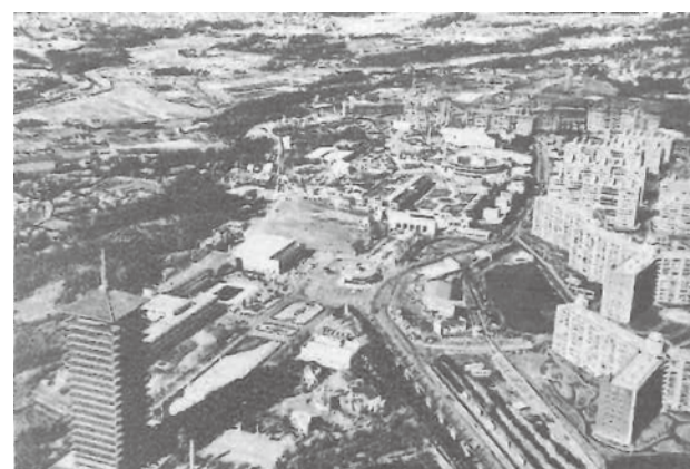
右側には建設中のドリームハイツ(年代不詳) 出典:「わたしたちのまち」深谷台小学校
