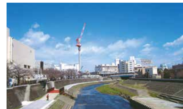
柏尾川から望む建設中の区役所(平成24年(2012年)) 提供:中野泰雄さん
