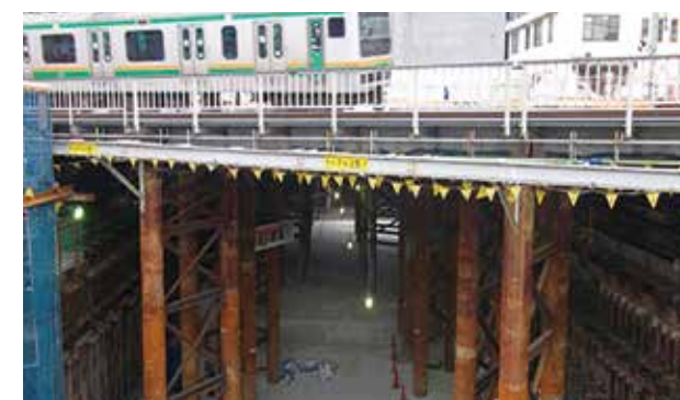
工事中のアンダーパスJR交差部(平成23年(2011年)) 出典:戸塚駅前地区中央土地区画整理事業事業誌
