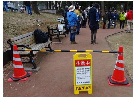
作業中標示の例
